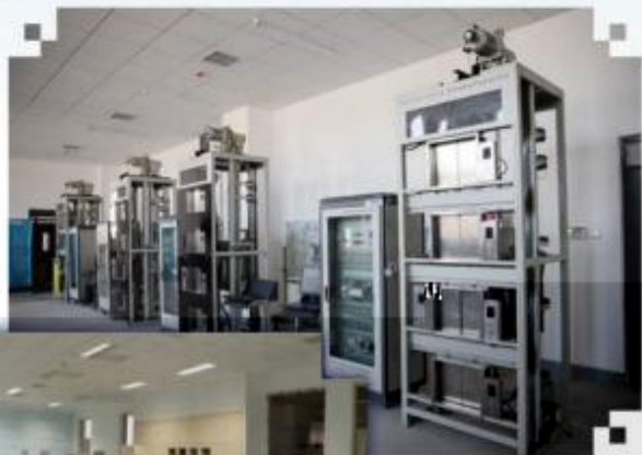
智能电梯安装调试 维护训练场所
